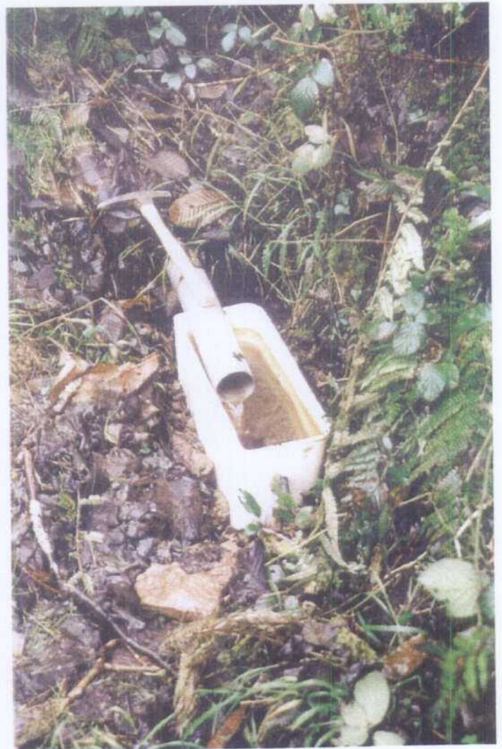
Detalle de la captación
