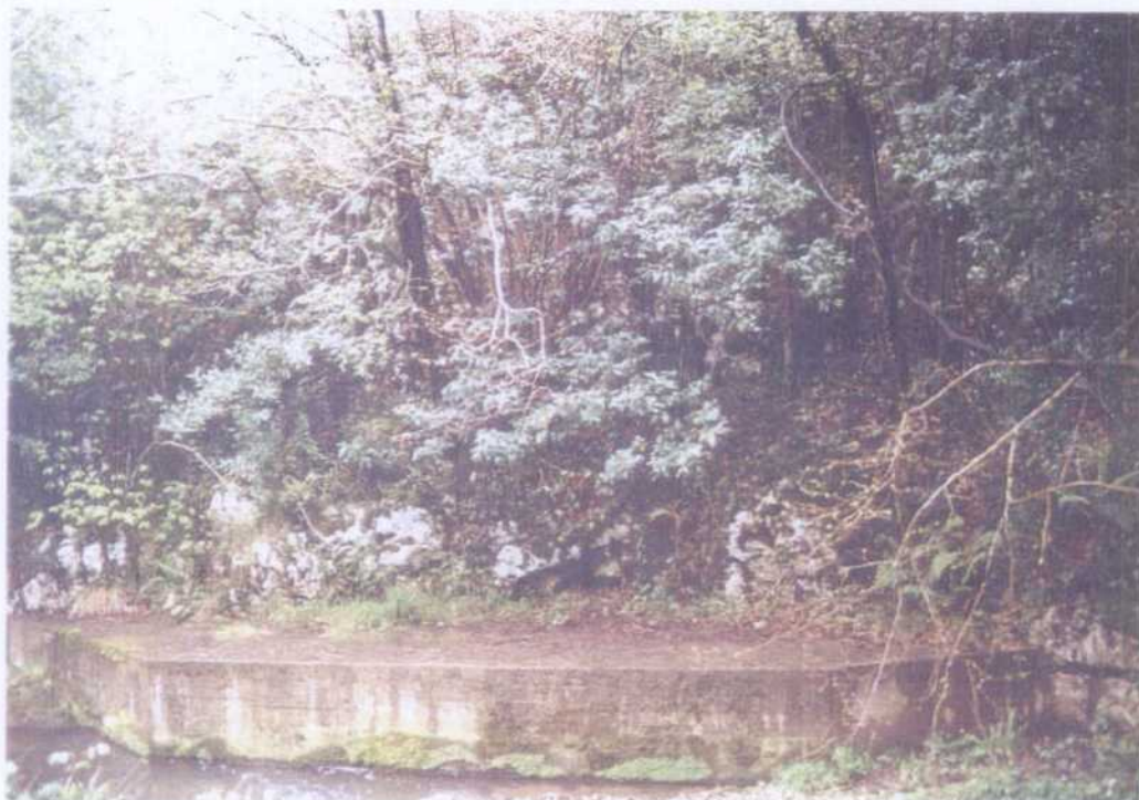
Captación del manantial
